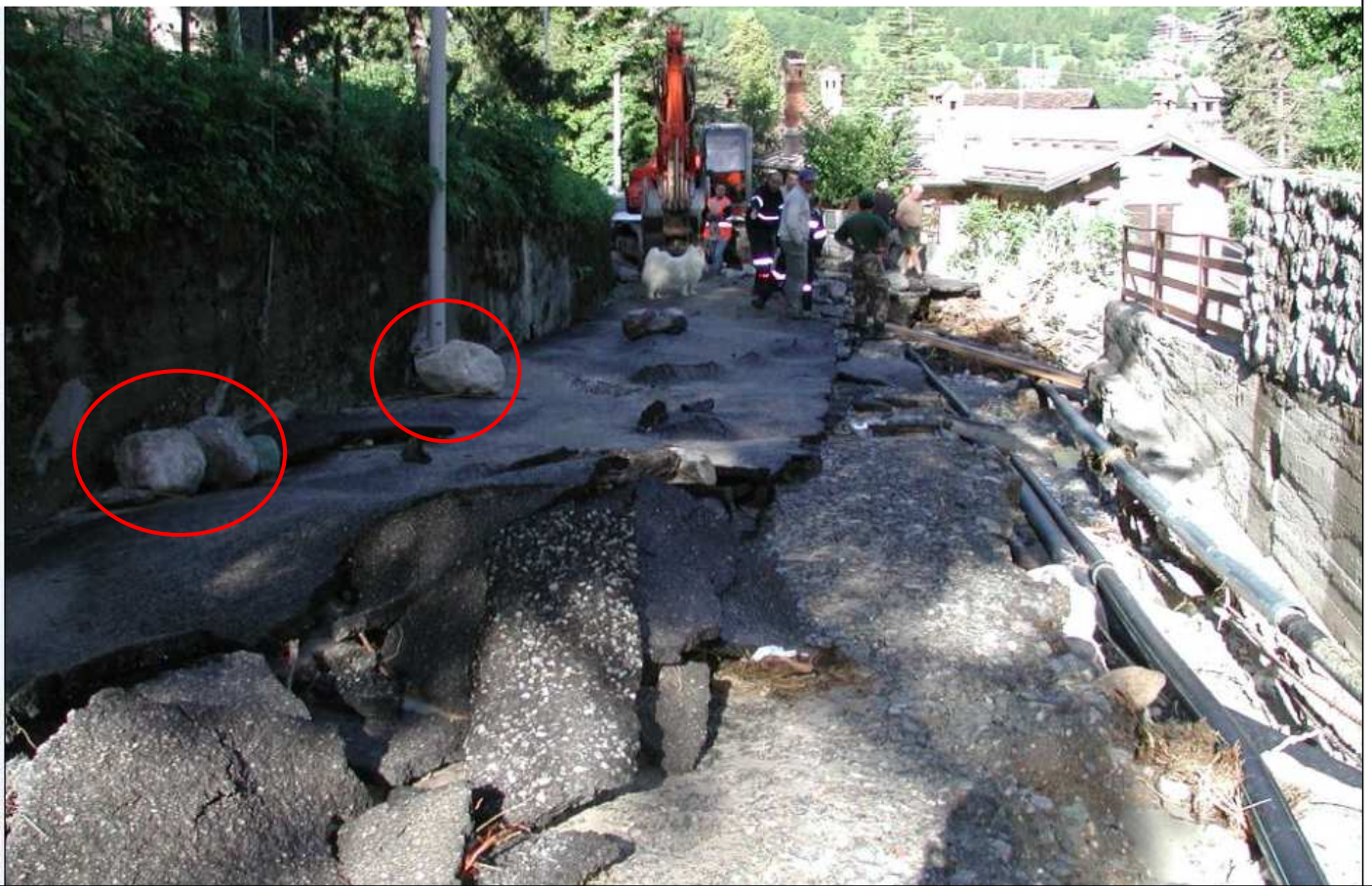
SI EVIDENZIANO I MASSI TRASPORTATI DALL' ENERGIA DELLA CORRENTE. SI OSSERVI COME L'ENERGIA DELLA CORRENTE E' RIUSCITA A SOLLEVARE L'ASFALTO E AD ASPORTARE TUBAZIONI E SOTTOSERVIZI FOTO EVENTO ALLUVIONALE LUGLIO 2002
