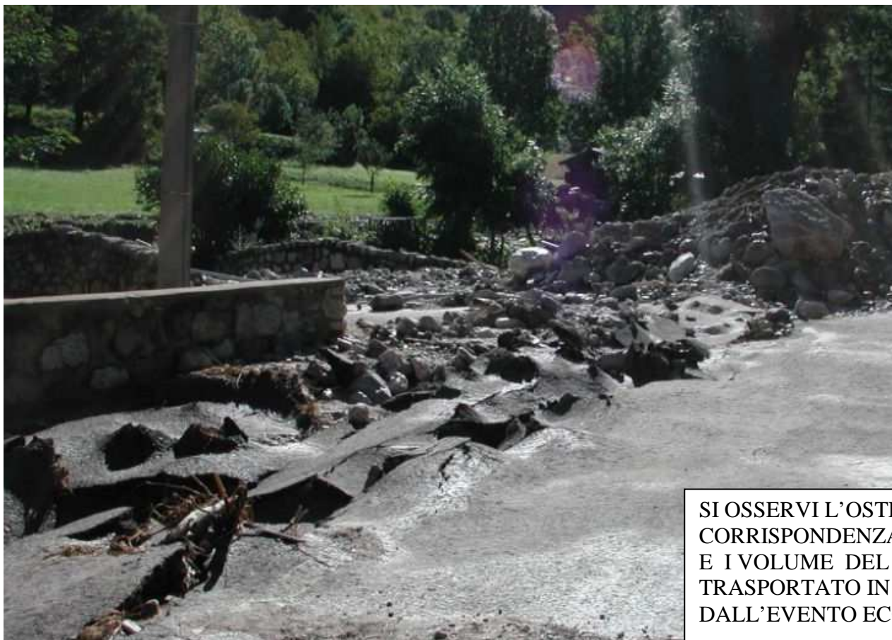
SI EVIDENZIANO I MASSI TRASPORTATI DALL' ENERGIA DELLA CORRENTE. SI OSSERVI COME L'ENERGIA DELLA CORRENTE E' RIUSCITA A SOLLEVARE L'ASFALTO E AD ASPORTARE TUBAZIONI E SOTTOSERVIZI FOTO EVENTO ALLUVIONALE LUGLIO 2002
